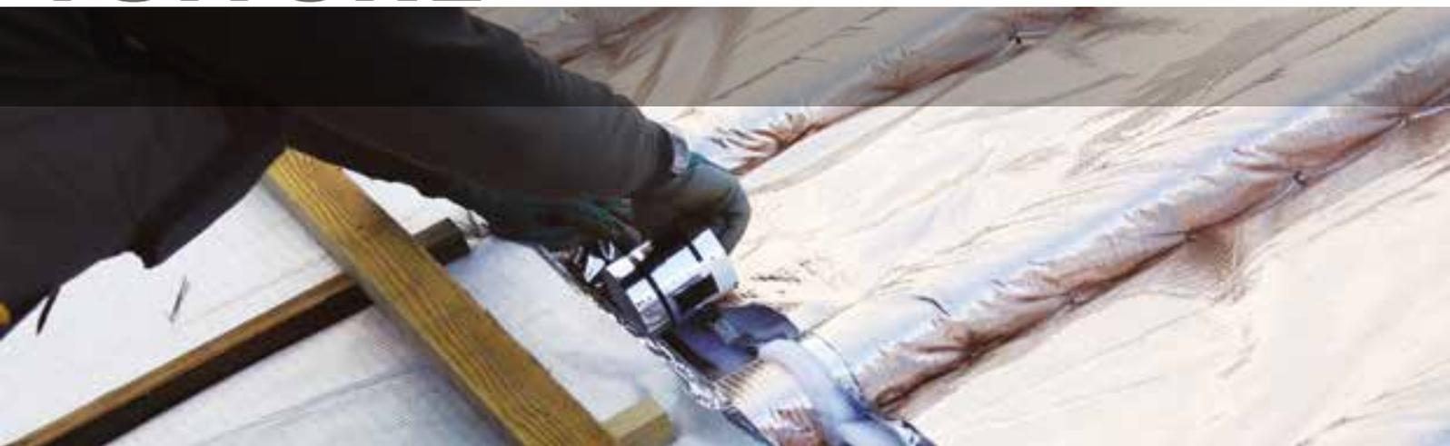
Mis en œuvre sur chevrons, le procédé TRISO-SUPER 12 BOOST<sup>®</sup> permet de bien isoler **sans surélever la toiture** tout en traitant l'étanchéité, ce qui fait réaliser des économies et gagner un temps précieux.
